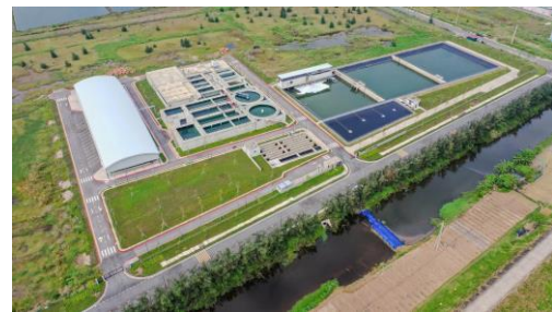
d. Nhà máy xử lý nước thải
