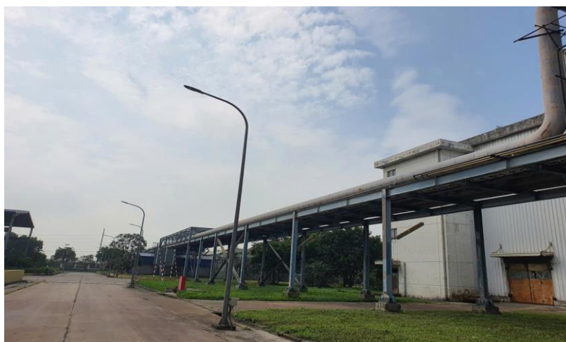
Hình 4.14. Đường dẫn khí CO 2 của Nhà máy đạm Ninh Bình tới Công ty Cổ phần Khí công nghiệp Ninh Bình tại Khu công nghiệp Khánh Phú (phường Đông Hoa Lư)
